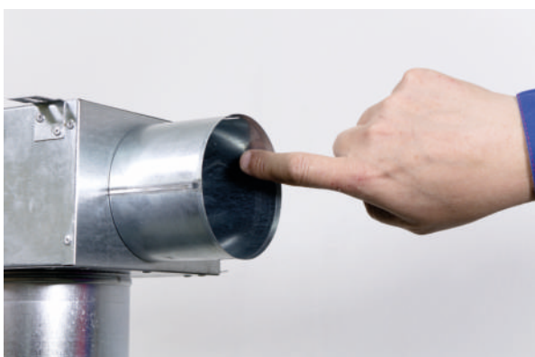
3) Vnitřní povrch vyústku namažeme kluzným přípravkem*.
